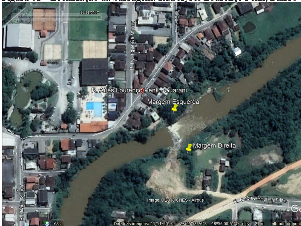
Figura 01 – Localização da barragem: Rua Ayres Lourenço Penk, Bairro Guarani.
