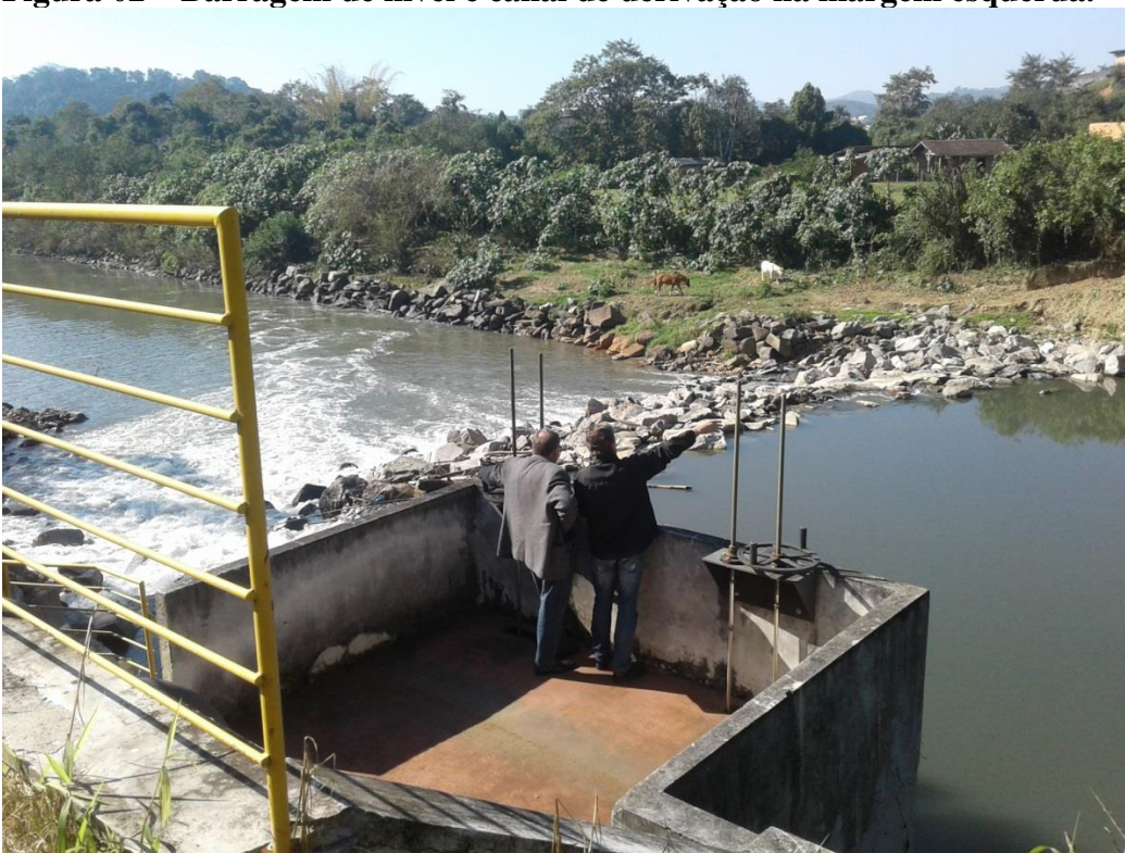
Figura 02 – Barragem de nível e canal de derivação na margem esquerda.
