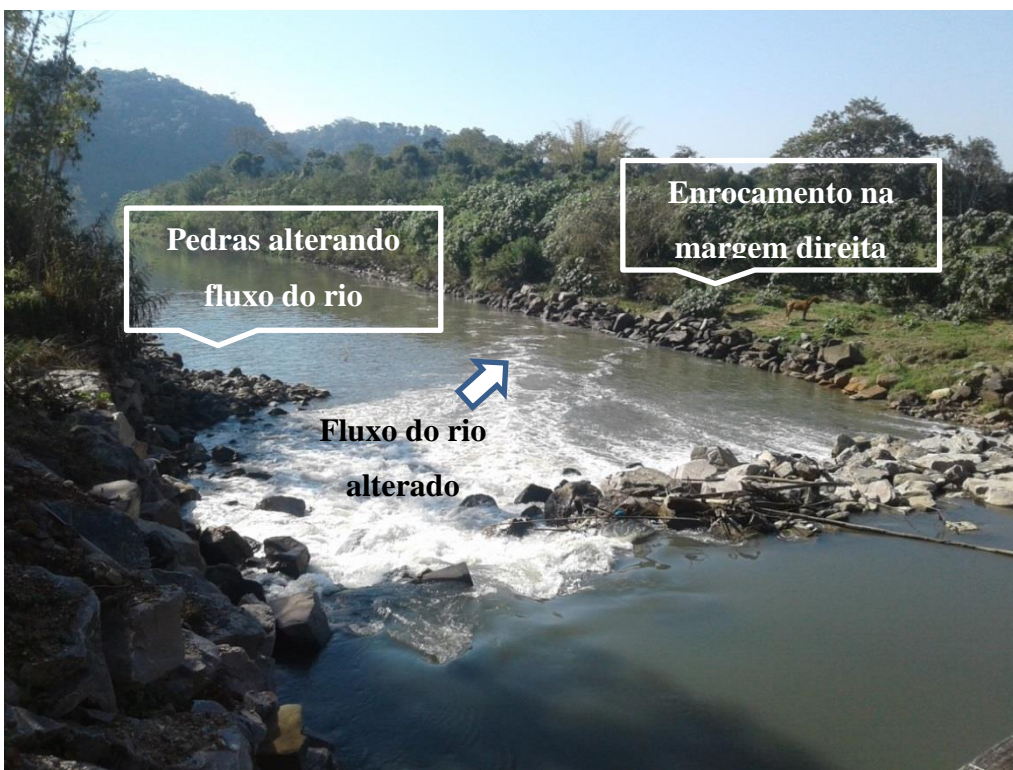
Figura 4 – Barragem de nível da captação de água bruta.
