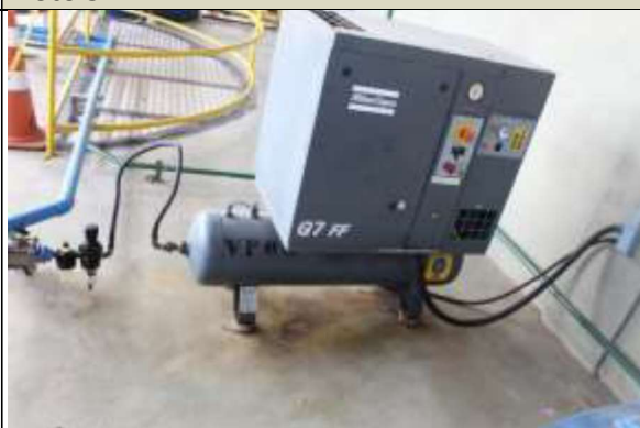
COMPRESSOR TIPO PARAFUSO 10HP VAZAO 45 PCM - 380V - IP55
