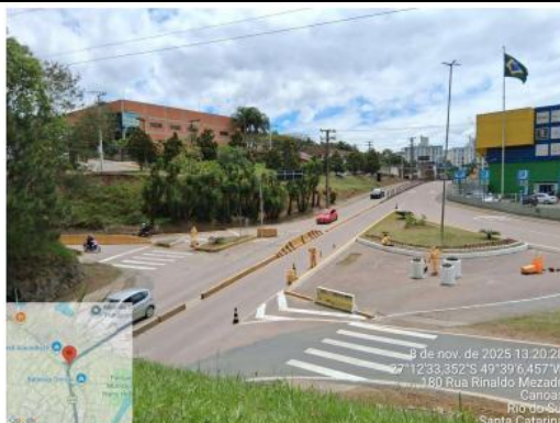
Figura 3 – Registro Fotográfico de via pública municipal recebendo a pintura após a realização da capina mecanizada.
