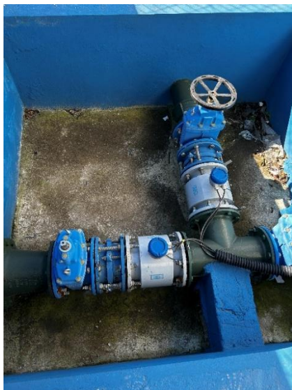
Figura 75 - Exemplos de tipologia de macromedidor na saída de cada elevatória do município.
