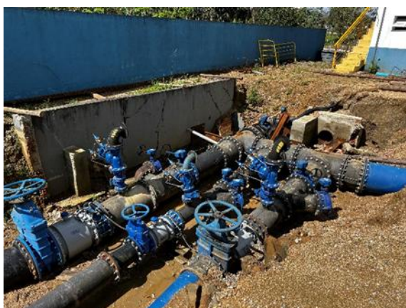
Figura 20 - Derivação da Adução de Água Bruta e Registros de Manobra
