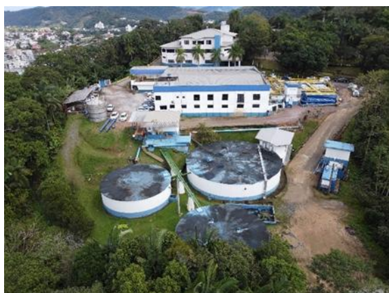
Figura 24 - Vista Aérea ETA Central
