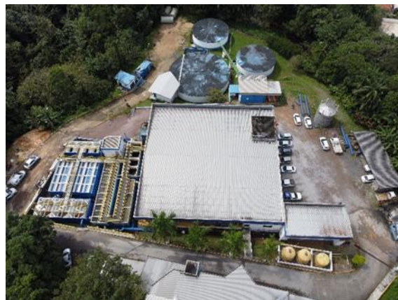
Figura 29 - Tanques de Armazenamento de Produto Químico
