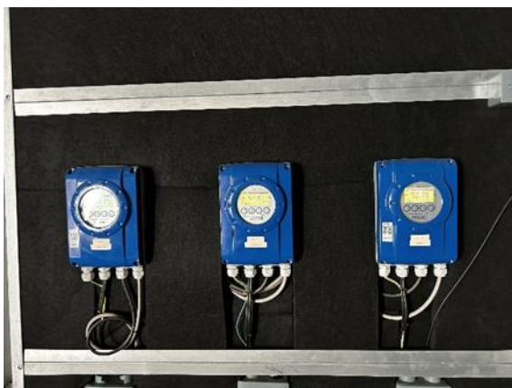
Figura 77 - Exemplos de acionamentos adotados nas elevatórias do município.
