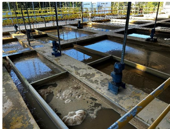
Figura 39 - Decantador
