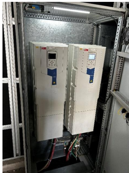
Figura 76 - Exemplos de acionamentos adotados nas elevatórias do município.
