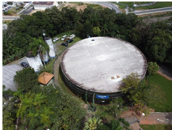
Figura 50 - Reservatório ETA Central
