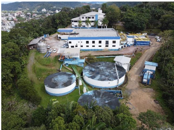
Figura 49 - Reservatório ETA Central
