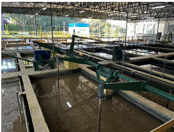
Figura 38 - Decantador
