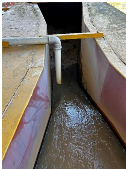
Figura 31 - Calha Parshall
