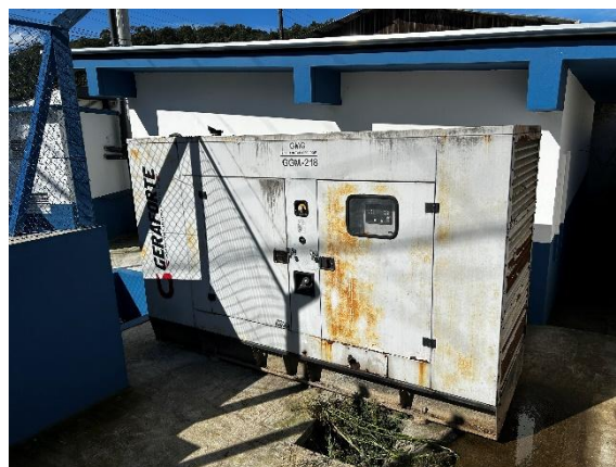
Figura 78 - Exemplos de acionamentos adotados nas elevatórias do município.
