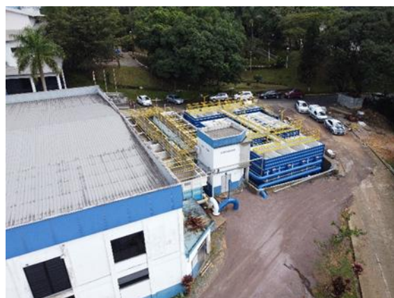
Figura 25 - Vista Aérea ETA Central
