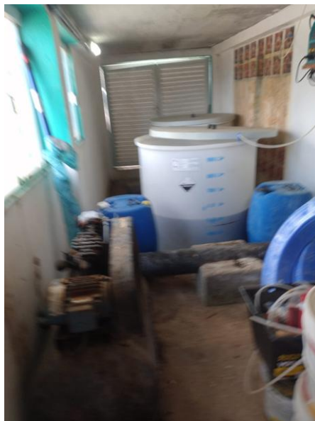
Figura 20 - Tanque de PAC e bomba dosadora (Canto superior direito)
