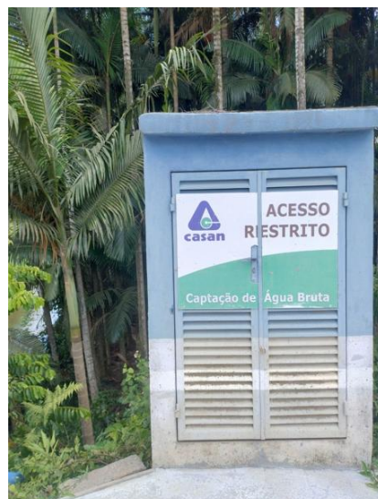
Figura 9 - Caixa de proteção do quadro de comando
