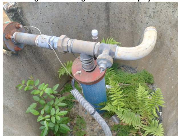
Figura 11 - Imagem interna do poço 1
