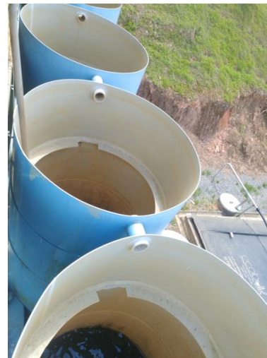
Figura 16 - Filtros de dupla camada ascendente
