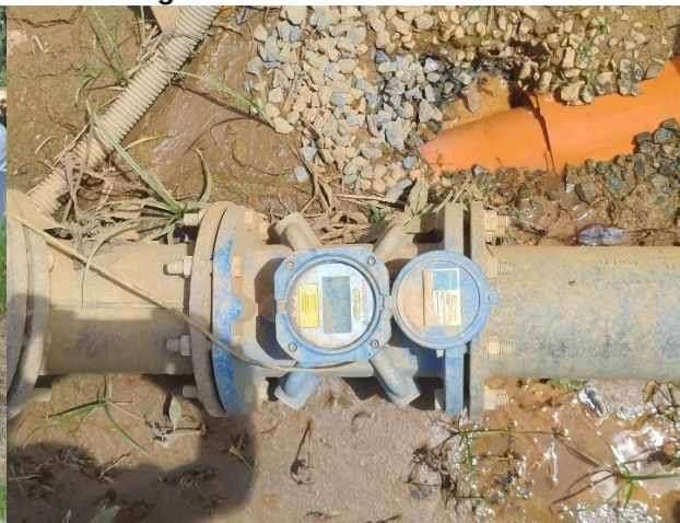
Figura 26 - Medidor de vazão
