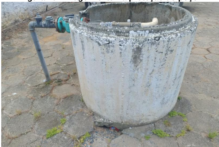
Figura 10 - Imagem externa proteção do poço 1
