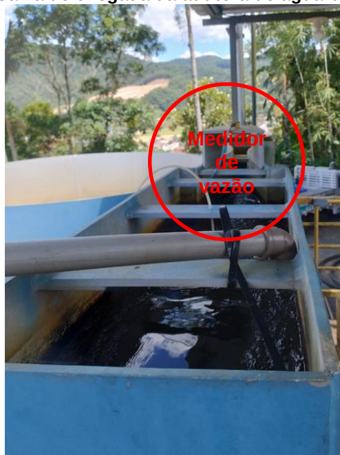
Figura 12 - Caixa de chegada da adutora de água bruta
