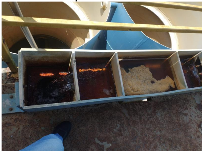
Figura 15 - Caixa de distribuição de água decantada para os filtros
