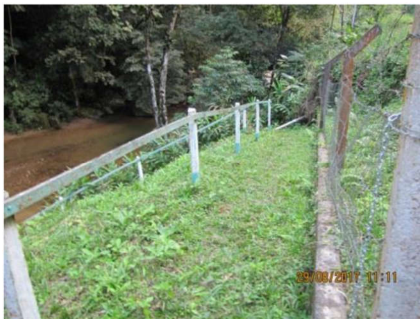
Figura 3. Captação da nascente do Sistema Rio dos Cedros
