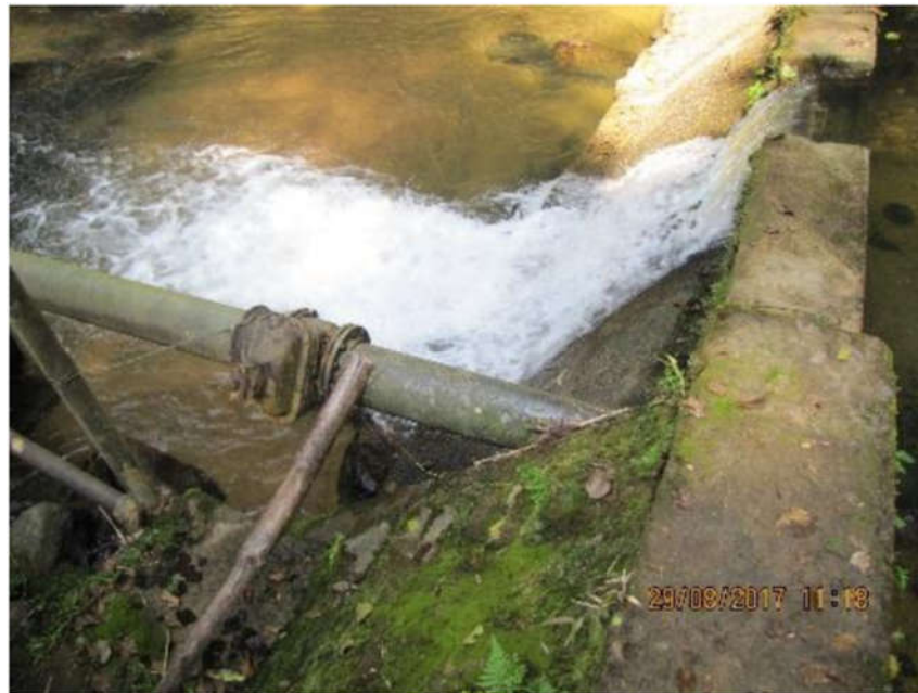
Figura 2. Captação Principal SAA Sistema Rio dos Cedros
